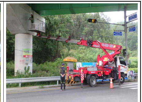
고소점검차를 이용한 조사(교각조사)
