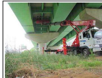
고소점검차를 이용한 조사(상부조사)
