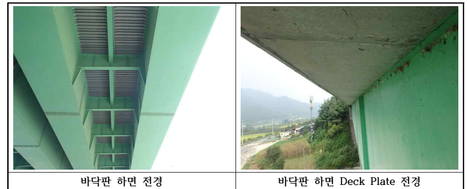
【사진 3.21】 바닥판 전경(여주)
