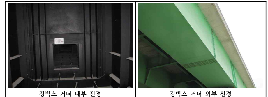
【사진 3.4】강박스 거더 전경(내서)
