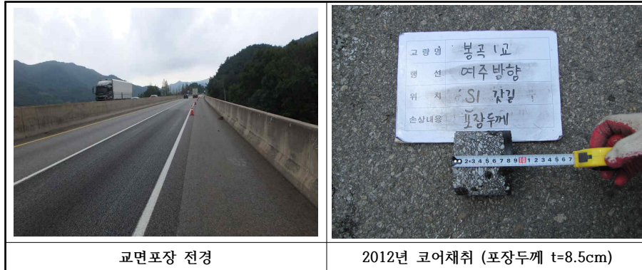
【사진 3.34】 교면포장 전경(여주)
