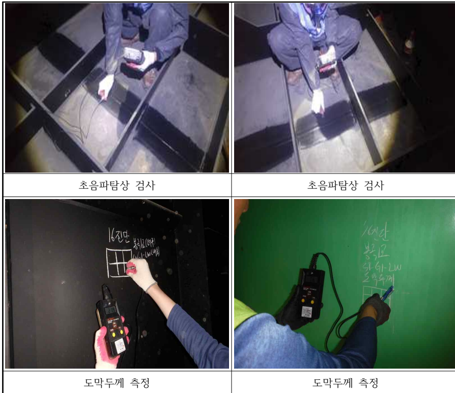
【사진 3.40】 강재 내구성조사 전경
