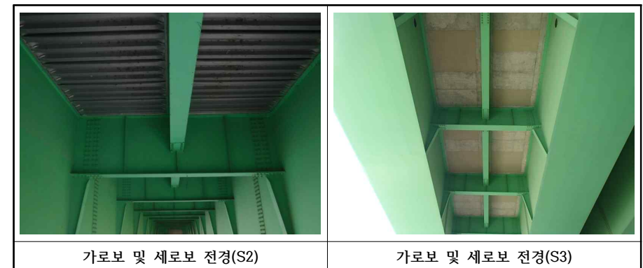
【사진 3.7】 가로보 및 세로보 전경(내서)
