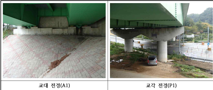
【사진 3.8】 교대 및 교각 전경(내서)
