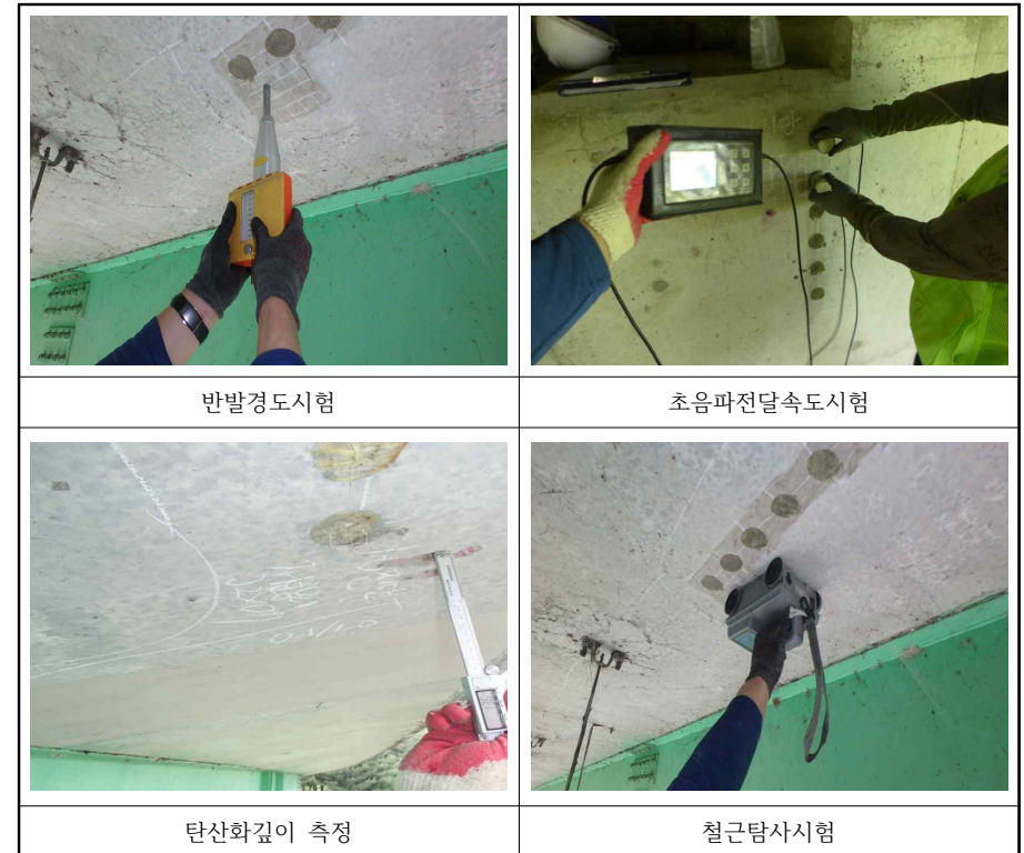
【사진 3.39】 콘크리트 내구성조사 전경
