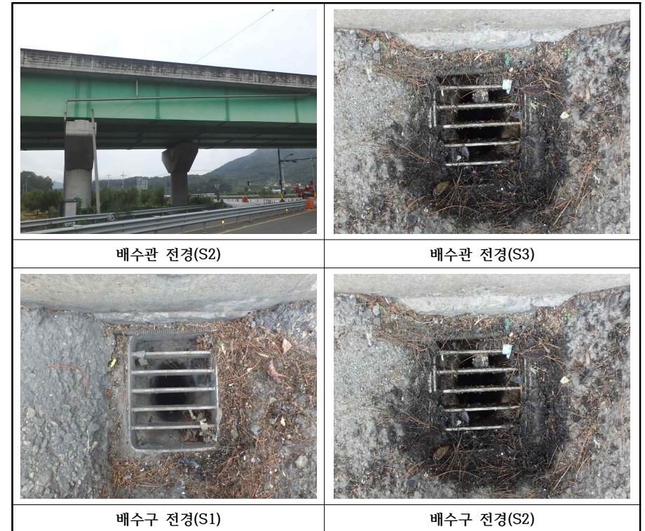
【사진 3.18】 배수시설 전경(내서)
