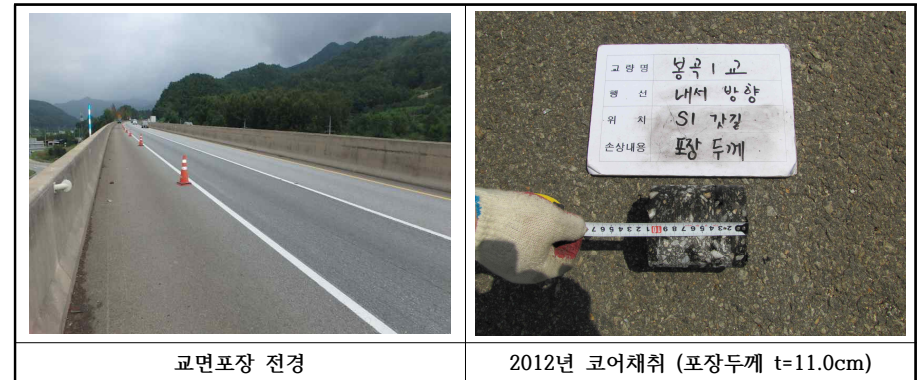
【사진 3.16】교면포장 전경(내서)
