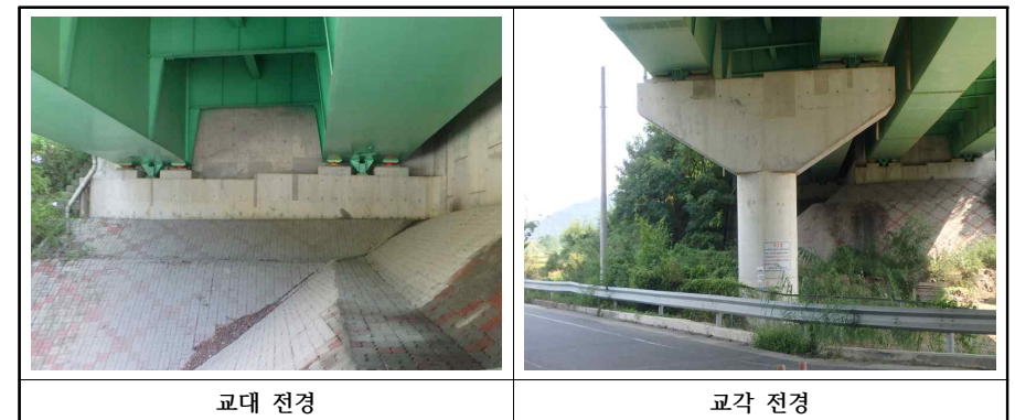
【사진 3.27】교대 및 교각 전경(여주)
