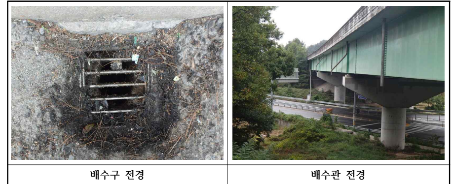
【사진 3.36】배수시설 전경(여주)
